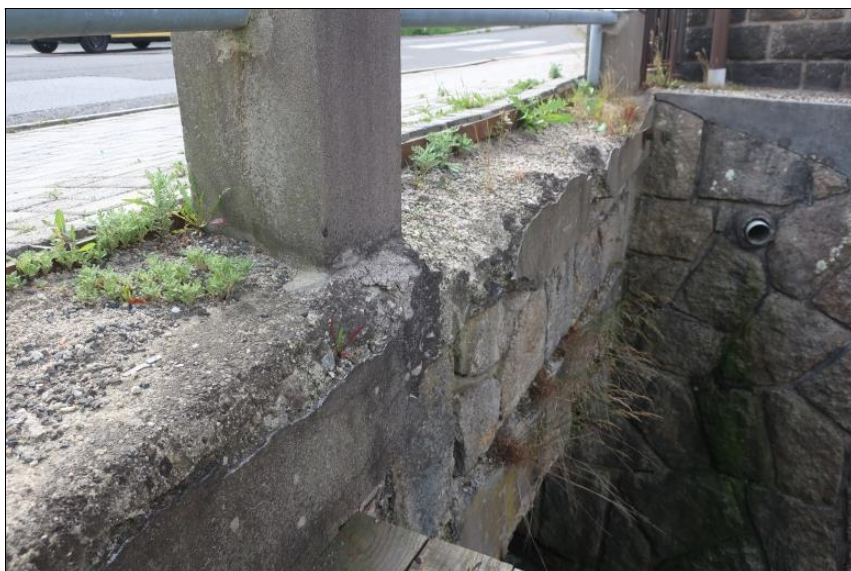
degradace betonu pravé římsy
