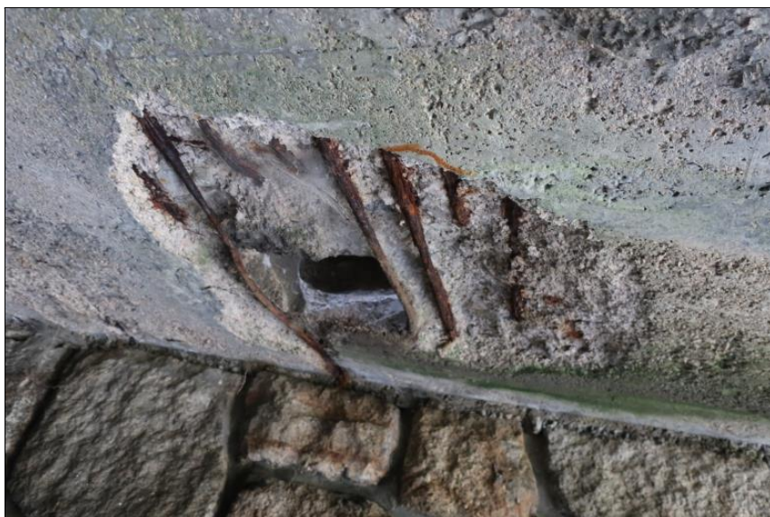
hloubková degradace betonu a koroze výztuže desky mostovky u vyústění odvodňovače
