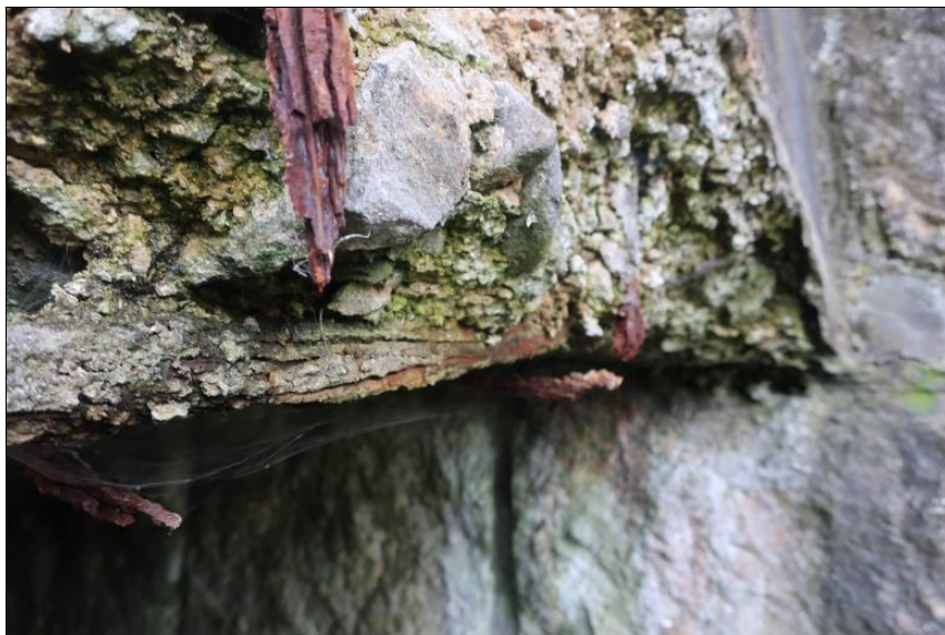
detail hloubkové degradace betonu desky v hraně
