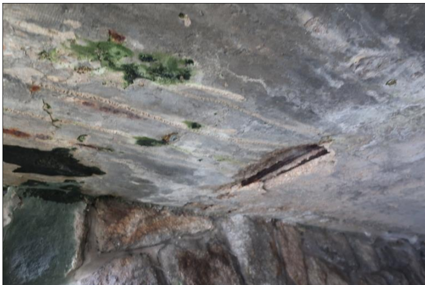
koroze obnažené výztuže na spodním líci desky mostovky
